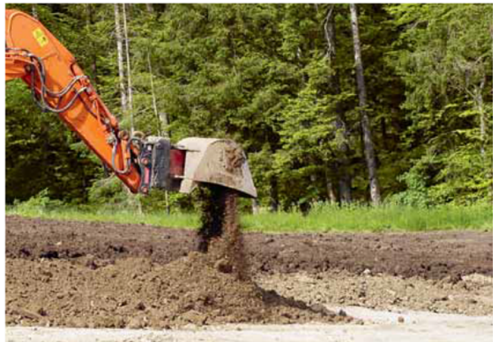
Mit Bodenrekultivierungen können minderwertige Böden zu Fruchtfolgeflächen aufgewertet werden. Dazu werden Ober- und Unterboden fachgerecht über den Untergrund eingebaut. Quelle: FaBo
