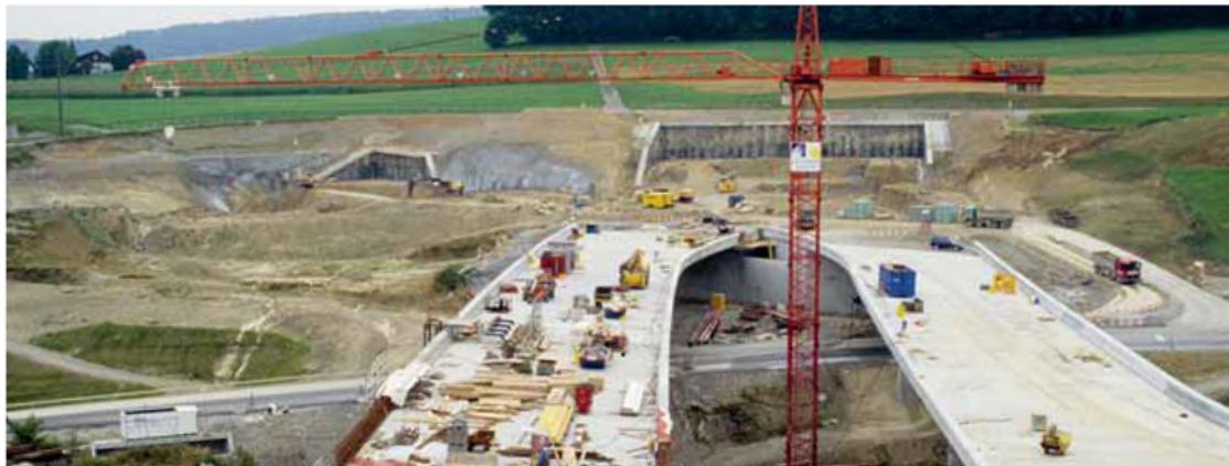
Durch Infrastrukturbauten, wie zum Beispiel den Bau der A3 in Birmensdorf, werden umliegende Böden temporär genutzt und anthropogen belastet. Die Rekultivierung kann sie anschliessend wieder aufwerten. Foto: FaBo
