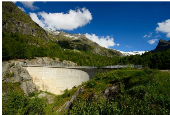
The Ferpèche dam (Photo: S. Ruttimann)
