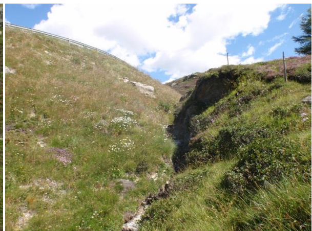
Abb.10: Umgelagerte Anlage links, rechts gewachsene Böschung.
