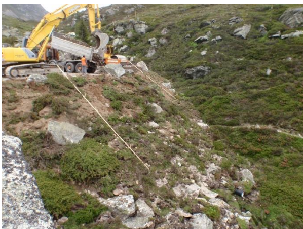
Abb.9: Böschungsaufbau mit Direktumlagerung von Borstgrasrasen und Zwergsträuchern.
