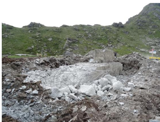
Photo 2 : Décapage de l'horizon supérieur du sol, puis démontage du socle et tri de l'armature et du béton (station amont).
