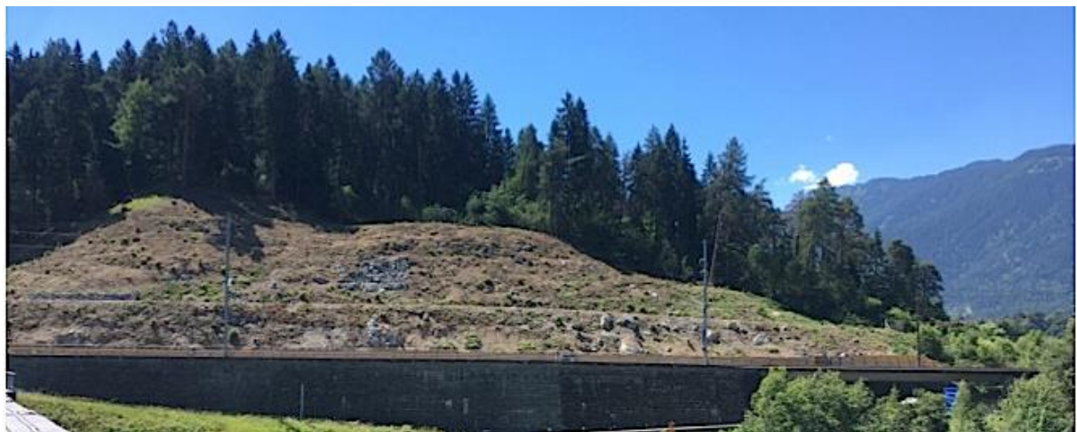
Abb.12: Dieselbe Hangfläche kurz nach Fertigstellung des Hangabtrags mit Direktumlagerung des vorhandenen Bodens mit Vegetation und Strukturelementen. Die Direktumlagerung erlaubt ein befriedigendes Resultat sowohl auf der Makro-, Meso- und Mikroebene: Landschaftlich angepasste Formung, heterogenes Relief, heterogene Bodeneigenschaften, Erhalt der autochthonen Flora und Mikrofauna. Somit konnte auf unangepasste, hangstabilisierende technische Verbauungen verzichtet werden.
