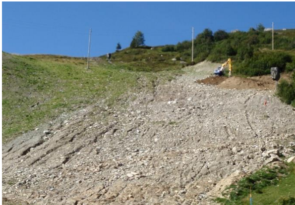
Abb.1: Erosion auf einer frischen, nach herkömmlichen Methoden angelegten Fläche.
