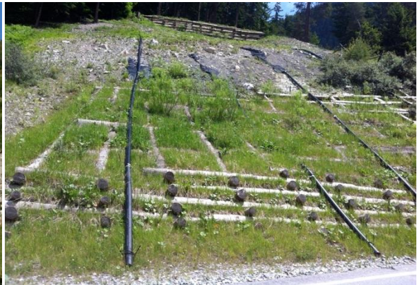
Abb.2: Technischer Versuch zur Hangwasserableitung und Begrünung einer landschaftlich nicht angepassten Strassenböschung.
