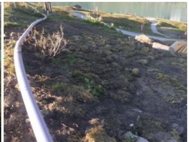
Abb.8: Derselbe Bereich direkt nach Fertigstellung und Anlage von Vegetationsziegeln.
