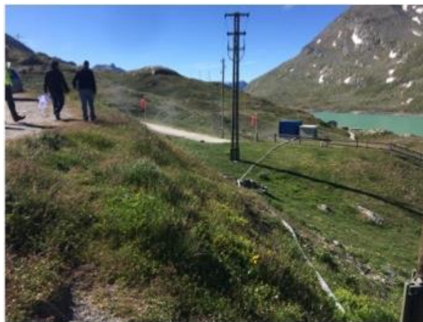
Abb.7: Böschung vor Leitungsbau.
