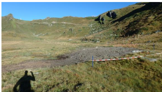
Photo 3 : à gauche: Socle démantelé, et sol fraîchement remis en place. Les milieux humides proches ont été soigneusement délimités pour éviter que les machines ne roulent dedans ou ne déposent des matériaux dessus; à droite: La même zone, une année après. Les ensemencements sont réalisés au cas par cas en automne, et réeffectués en cas de besoin au printemps suivant, voir à l'automne suivant.
