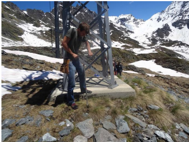
Photo 1 : Prélèvement de sols pour analyses avant démantèlement des anciens pylônes.
