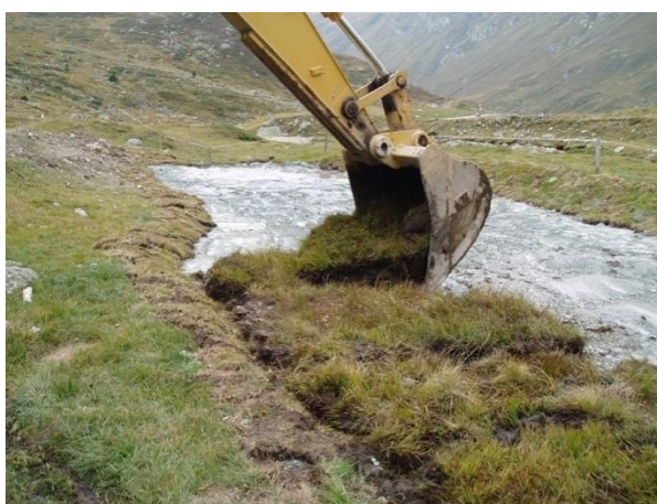
Abb.4: Direkte Umlagerung von Flachmoor-Soden.
